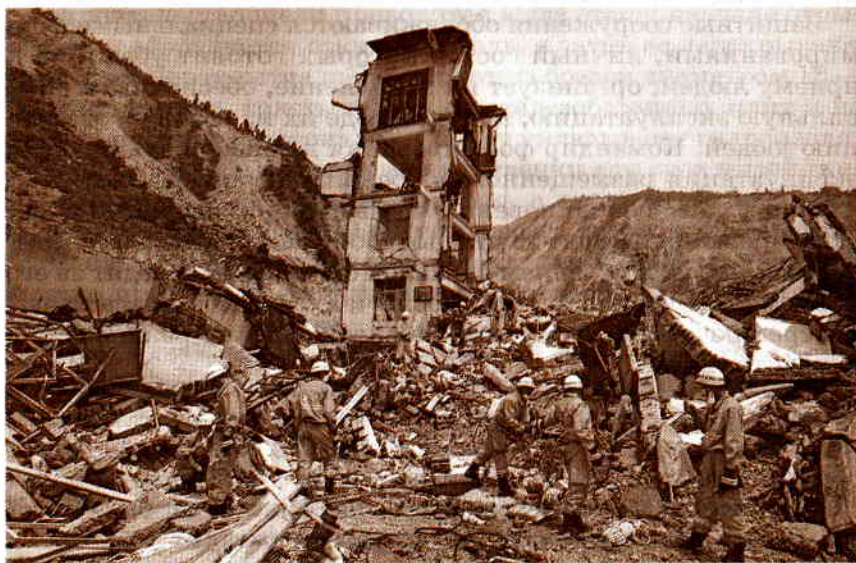
Рис. 22. Аварийно-спасательные работы после обрушения здания
